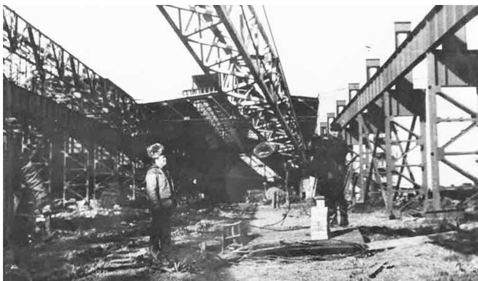
Строительство трубного цеха. Начало 80-х годов
